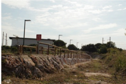
Cheminement doux traversant la voie ferrée
