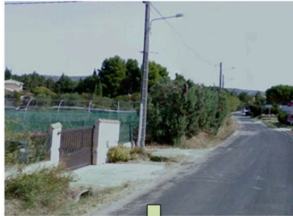
Continuité piétonne aménagée sur la route d'Opoul
