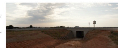
Passage piéton sous la RD 900
